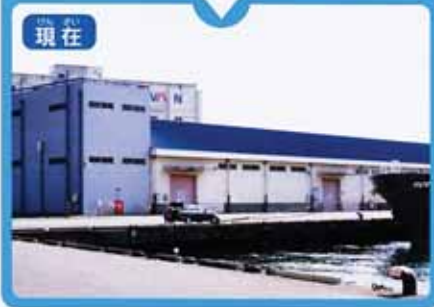
上屋(荷物を一時的に保管する倉庫)
