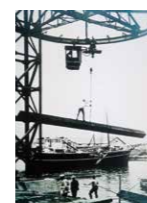
▲昭和初期、木材を陸揚げする テルファー（機械遺産） 昭和初期，用于木材卸货的 机械缆车（机械遗产）
