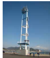
津波待避所を備えた 照明塔 设有海啸躲避处的照明塔
