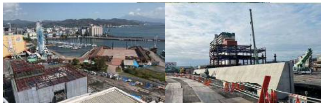
防潮堤建設現場
